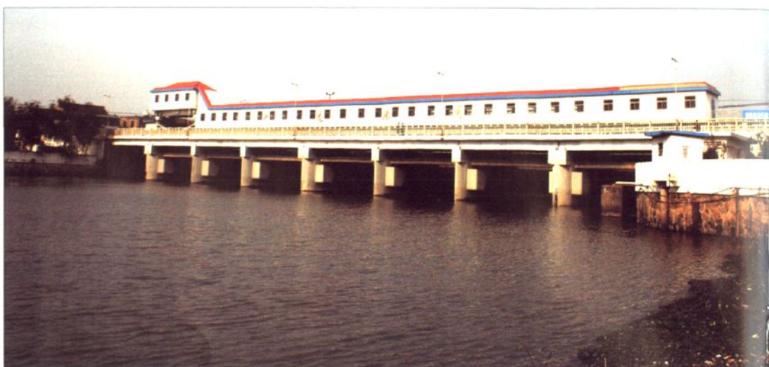
▲ 里下河地区四大港闸之一——斗龙港闸 (建于1966年6月)
