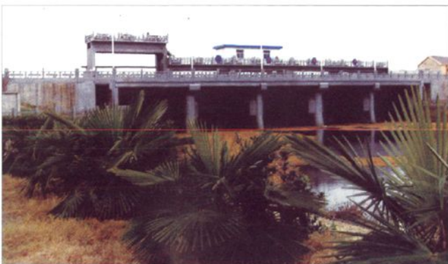
▲ 川东港闸 (建于1966年5月)
