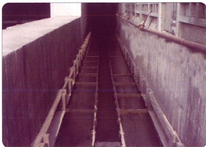
▲ 斗龙港闸鱼道（建于1966年6月）
