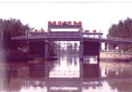
▲ 四卯西节制闸 (建于 1977 年 5 月)
