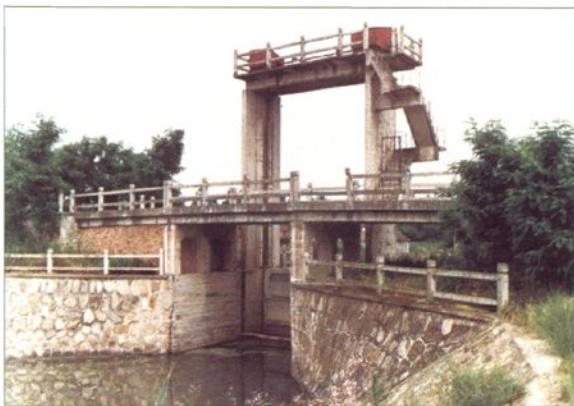
▲ 黄海复河节制闸 (建于1985年7月)
