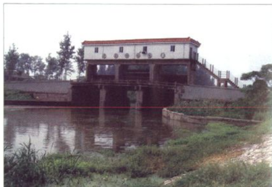
▲ 王港调节闸 (建于1963年3月)
