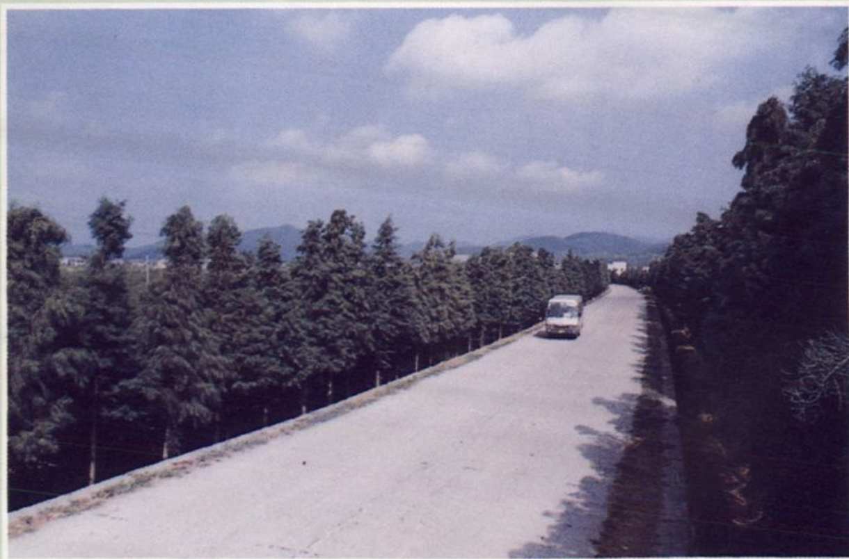
骆驼—汶溪公路
