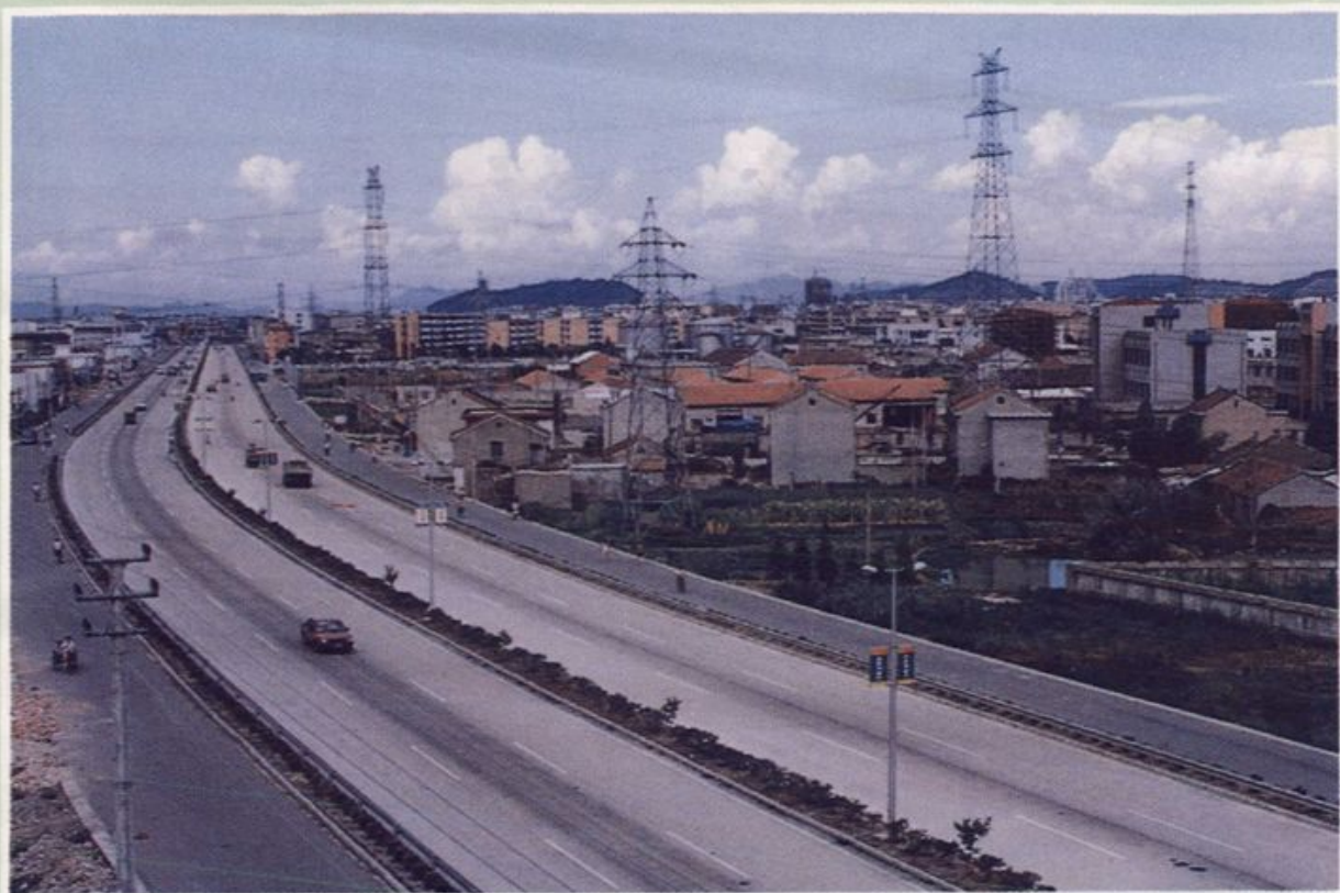
镇海—宁波一级公路
