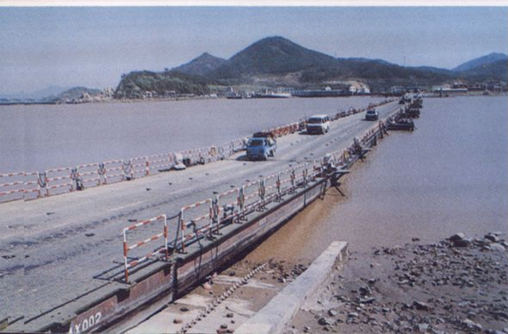
大榭岛跨 海浮桥
