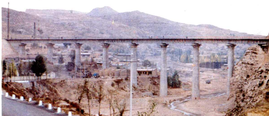
峙峰山矿铁路桥
