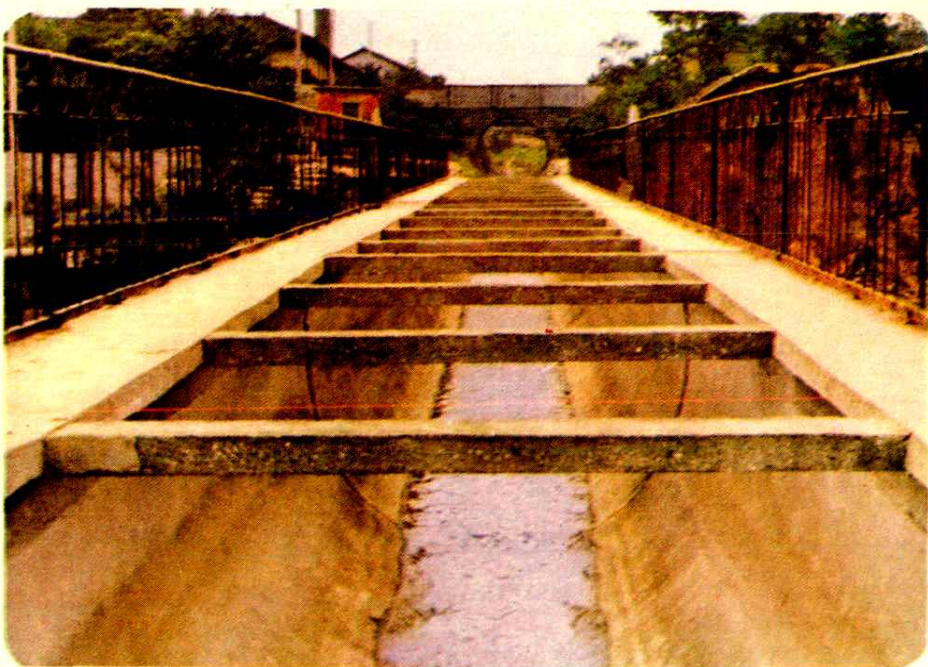
十四、红岩渠马尾河薄壳渡槽
