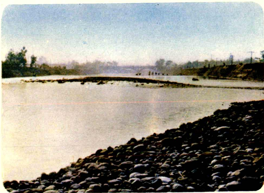
十八、射水河治河筑堤工程——板桥段
