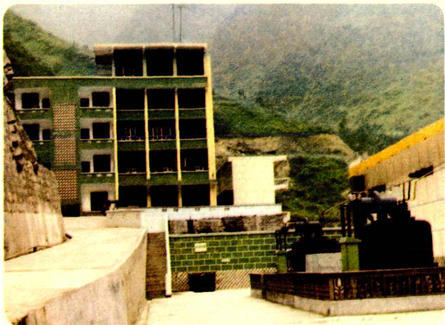
廿一、新建投产 装机3200瓩“小岗剑”电站
