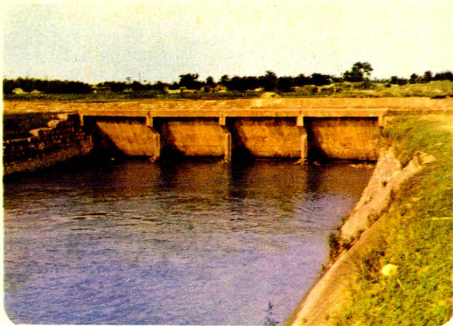
十五、人民渠输水80秒，立方米甘河子倒虹涵洞
