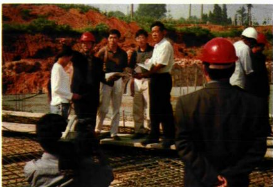
2002年8月30日县委书记周宗、县长唐德荣、副县长保明富等县委领导同志到水桥小学建设工地视察。
