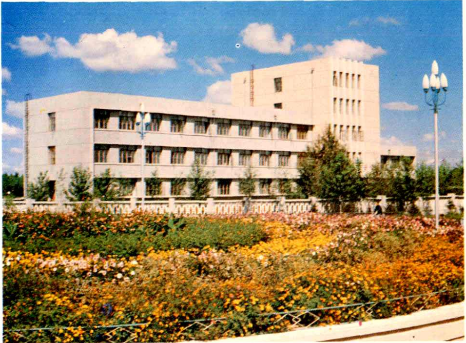
林源炼油厂办公楼
