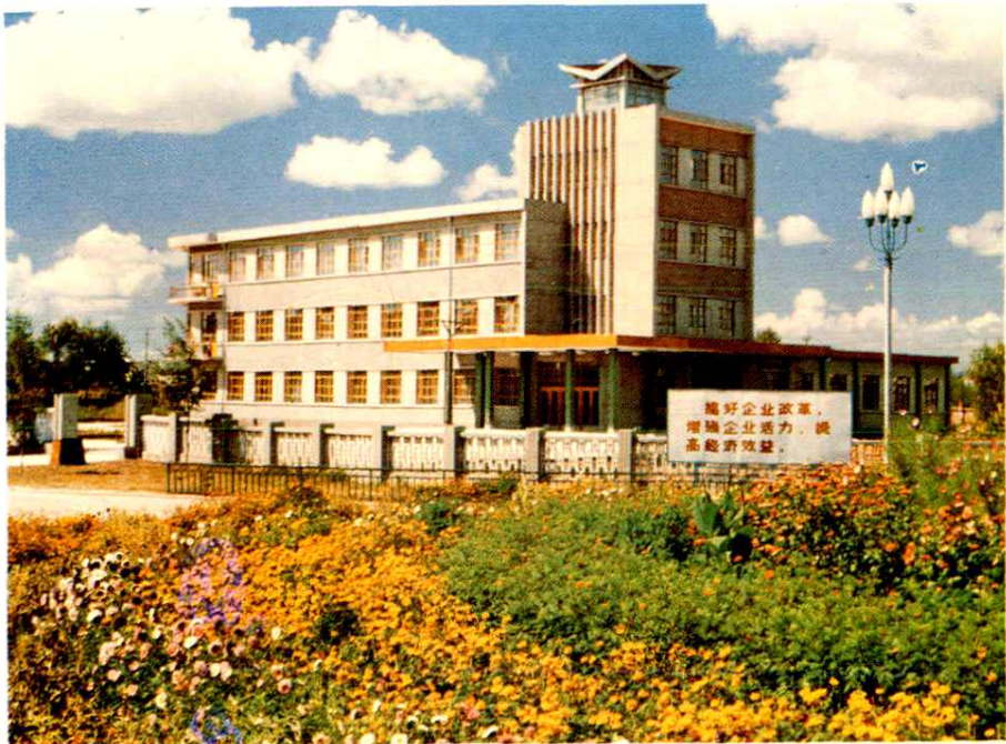
林源炼油厂科技楼
