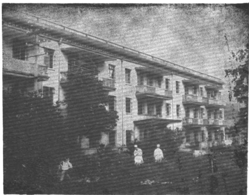
县第一人民医院住院部
