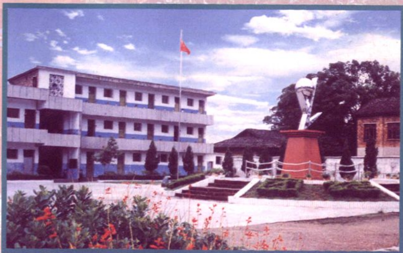
严田中学校园一角
