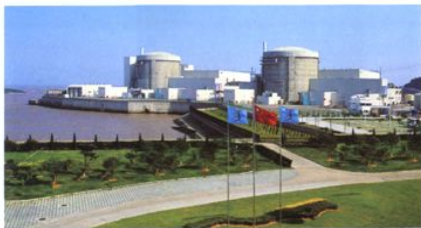
秦山核电三期全景
