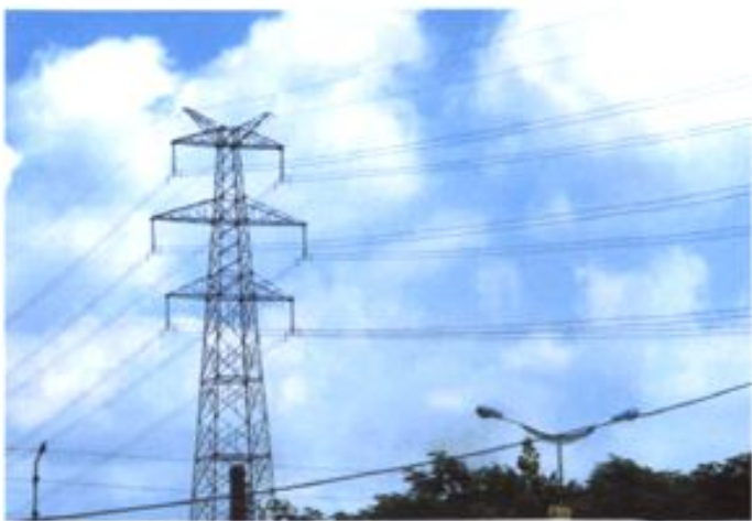
2003年,嘉兴市首条采用双回路、双分裂导线、OPGW复合光缆设计的220千伏南瓦线投运
