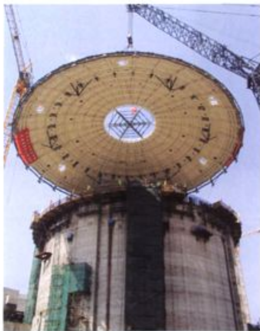
2001年7月,秦山核电三期2号反应堆下穹顶吊装顺利就位
