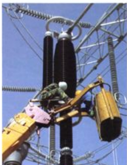
500千伏王店输 变电工程施工建设
