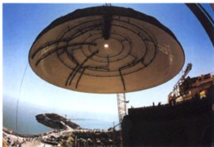
1998年11月10日,秦山核电 二期工程1号反应堆厂房封顶
