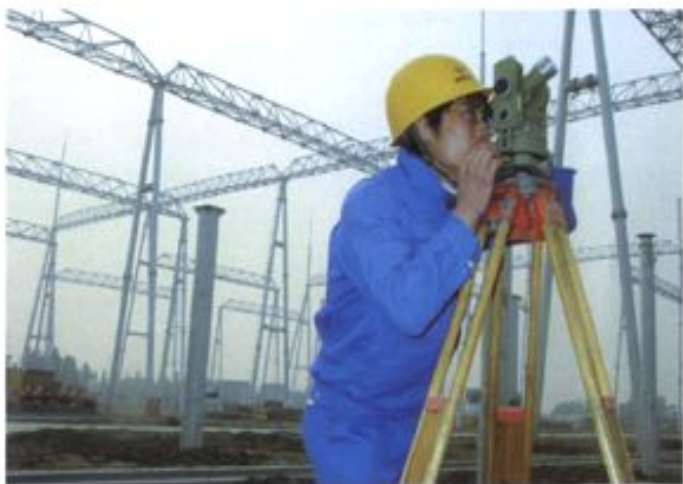
2005年,建设中的500千伏汾湖变电所
