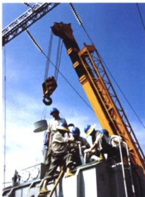
2005 年, 嘉兴市第一座 220 千伏变电 所——南湖变电所进行主变压器大修
