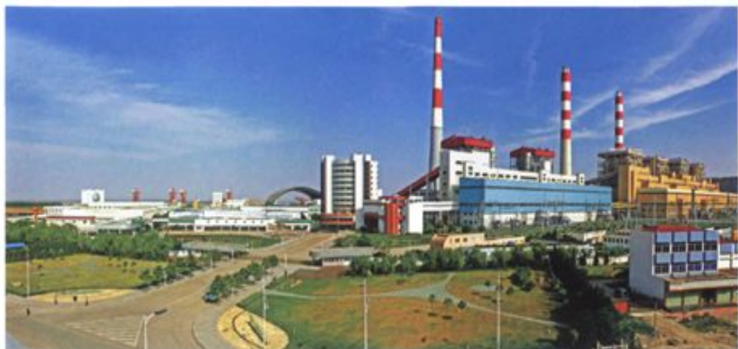
嘉兴发电厂全景
