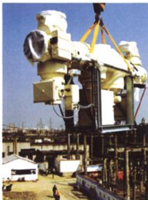
2002 年, 嘉兴市第一座 110 千伏变电所—— 嘉兴变电所进行原地改造建设
