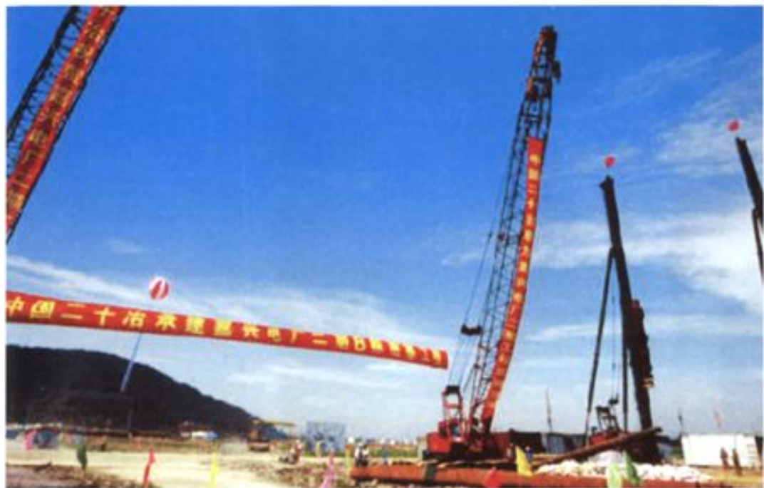
2002年1月,嘉兴发电厂二期工程主厂房开工建设
