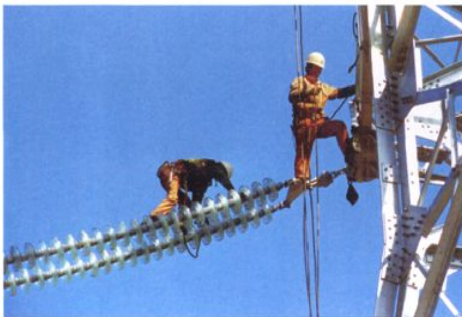
500 千伏嘉王线施工现场
