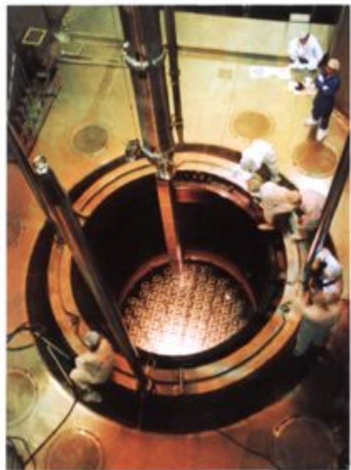
秦山核电二期施工人员更换燃料组件
