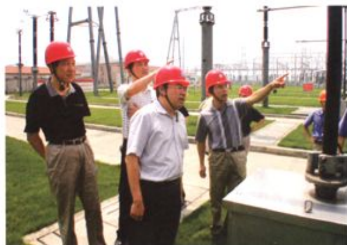
2004年7月11日,华东电网公司副总经理贺锡强(中)在500千伏王店变电所进行夏季用电检查
