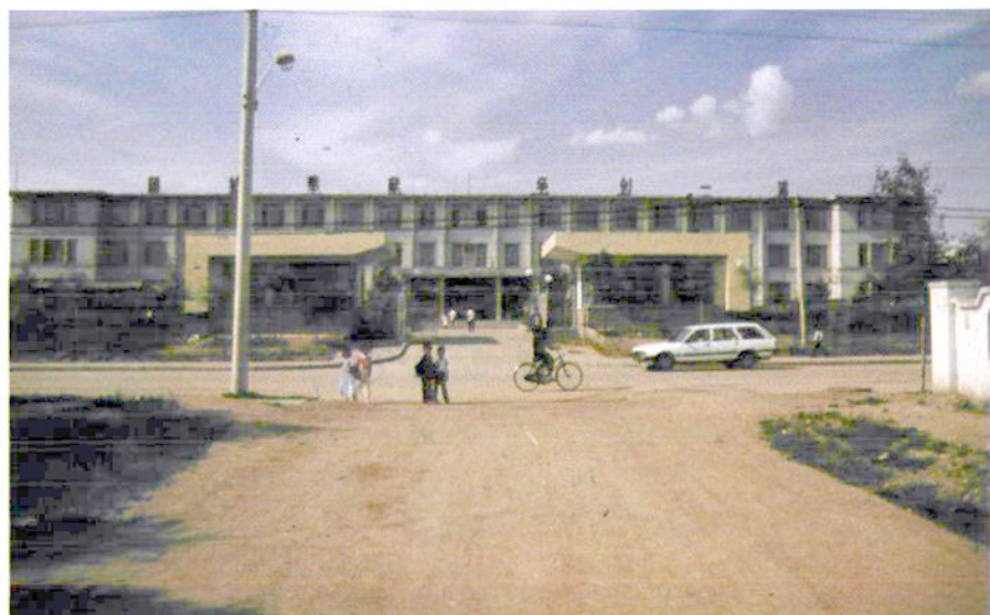
林业局办公室主楼
