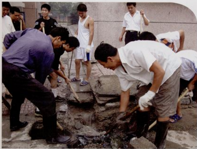
众人合力疏通下水管道
