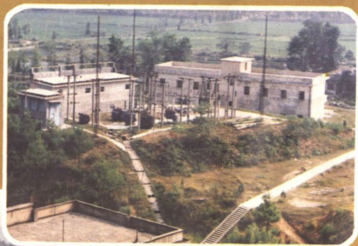
军民水电站 35 千伏变电站全景
