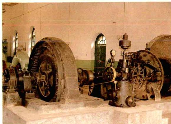
石龙坝发电厂第一台 240 千瓦水轮发电机组
