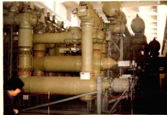
鲁布革发电厂 220 千伏 SF<sub>6</sub> 组合电器
