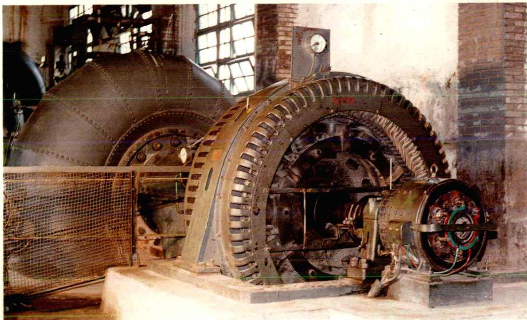
石龙坝发电厂 720 千瓦水轮发电机组
