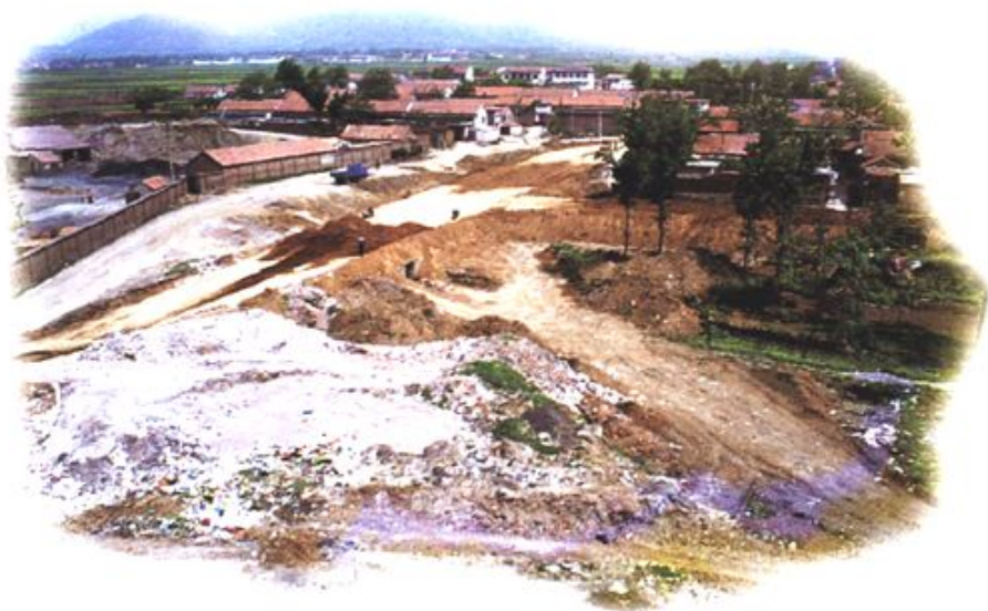
顺河路施工现场
