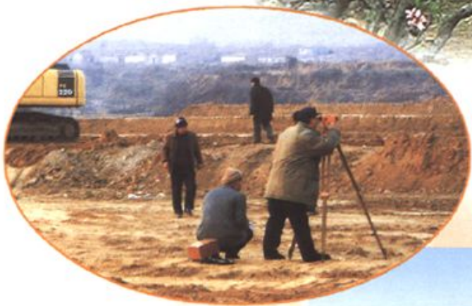
大陡沟整平土地
