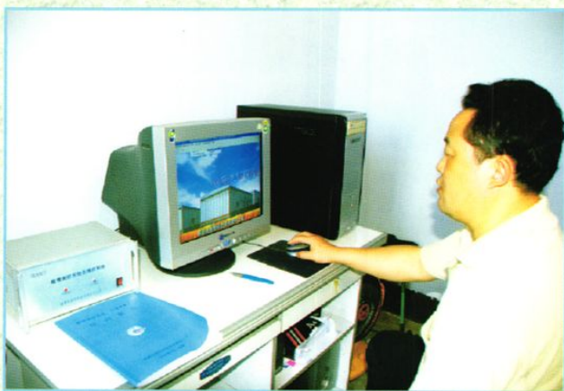
粮情微机巡测系统
