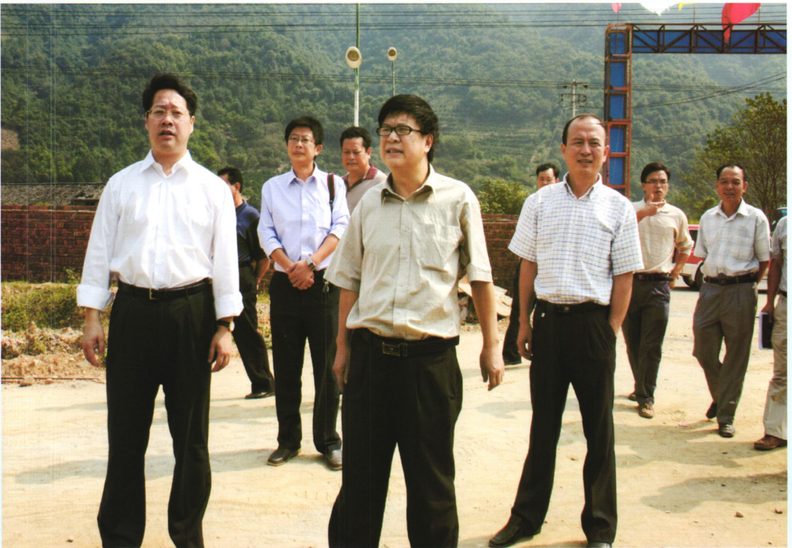
崇义县人民政府县长邱建军（左一）率有关领导和部门人员到崇义县人民检察院技侦大楼工地了解建设情况
