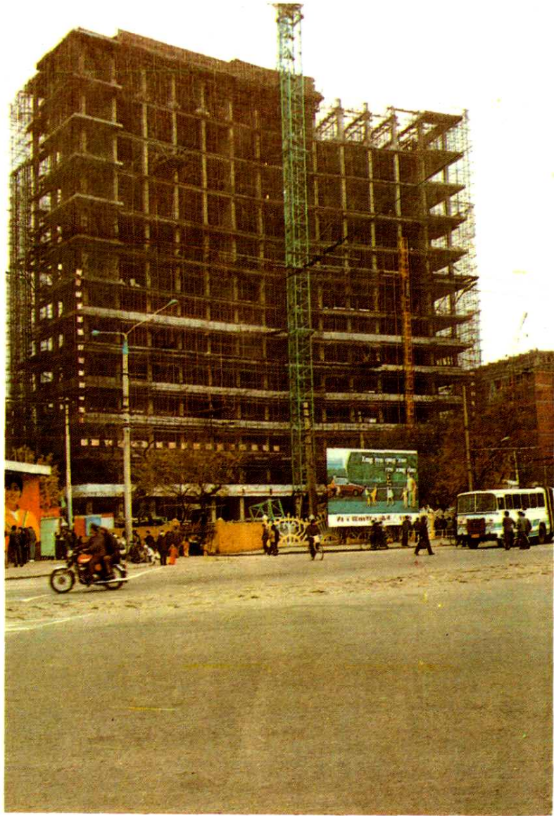
正在建设中的电力调度楼
