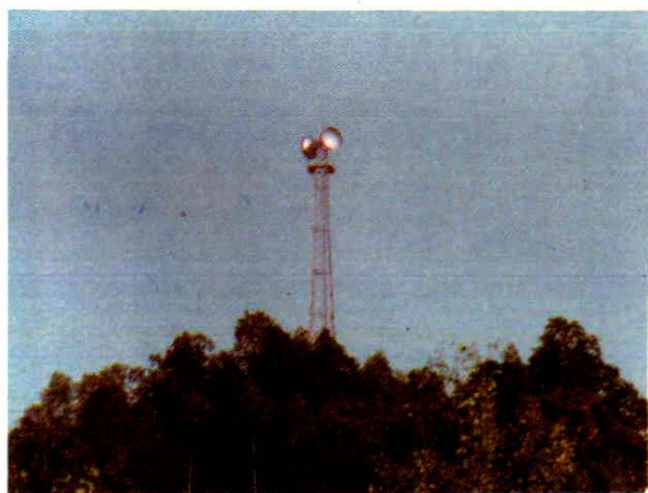
无人站微波塔
