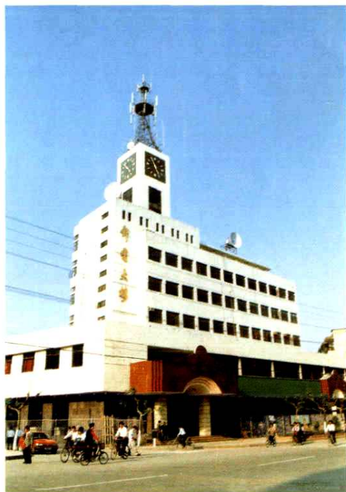
瑞安市邮电大楼
