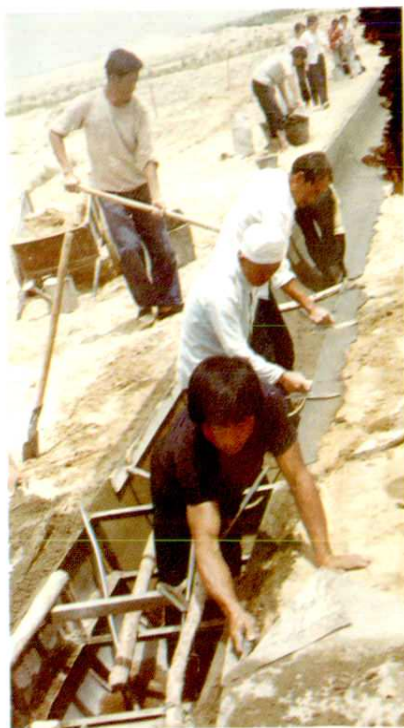
沙 地 修 U 型 水 渠
