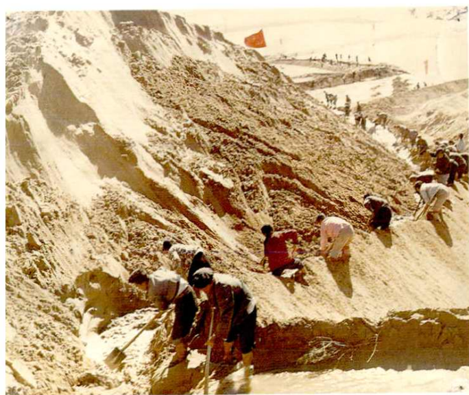
引水拉沙修地
