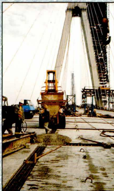
上海白水泥厂生产的U型混凝土膨胀剂用于杨浦大桥工程
