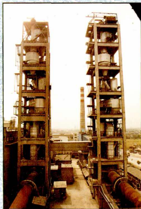
1990年上海宝山水泥总厂从日本引进干法生产线
