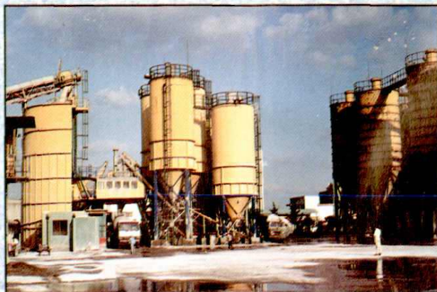
上海建工材料公司长桥搅拌站
