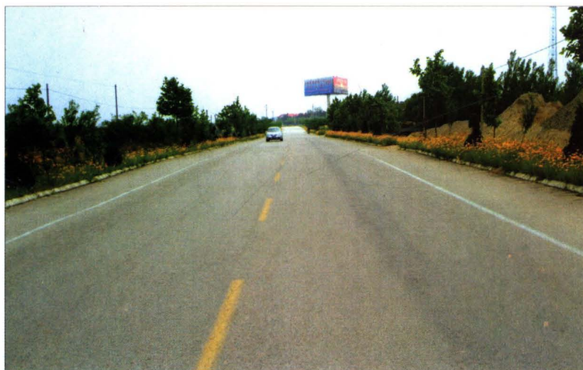
县道黄草线 建设、绿化景况
