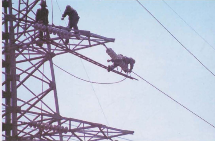
14 220千伏李东线 在施工中
