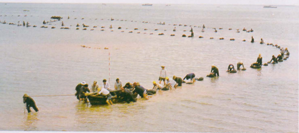
13 1988年5月开工的220千伏集美至高崎海缆工程在施工中
