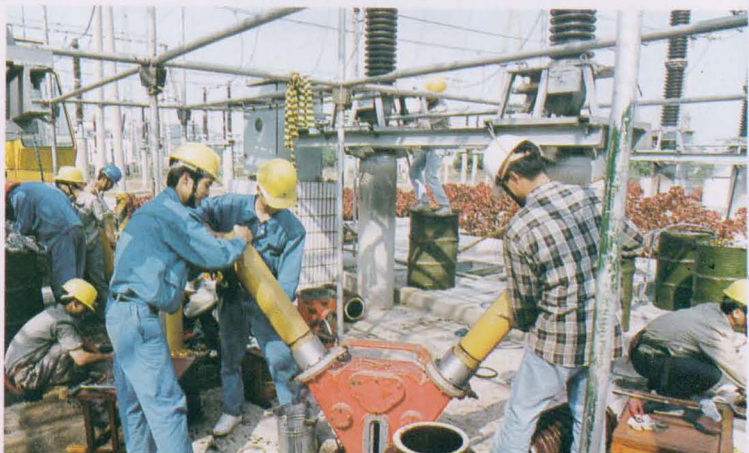
19 认真维修 变电站
