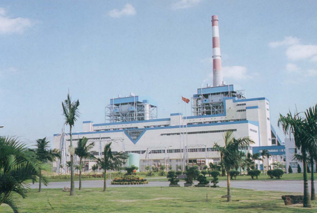
9 厦门嵩屿电厂外景
