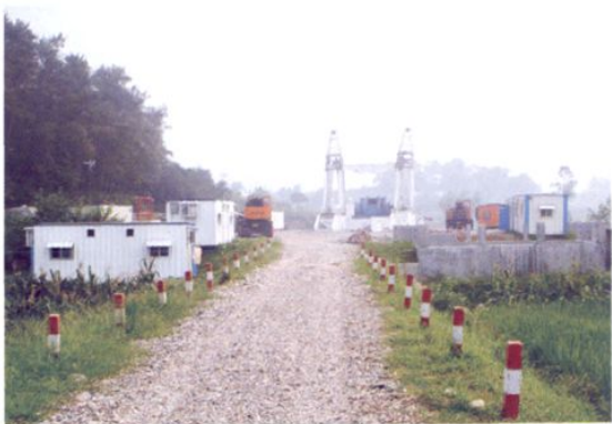
△中国石油西南油气田公司正兴码4井
