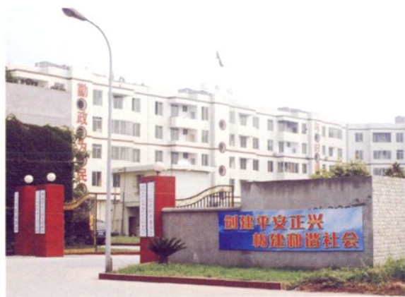
△正兴镇人民政府办公楼
