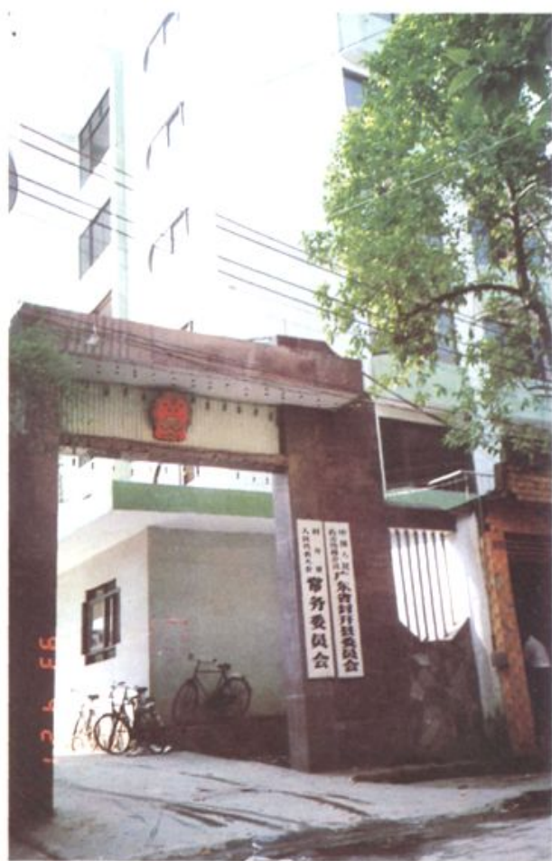
封开县人大常委会办公楼
