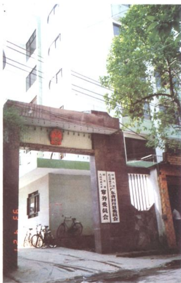
封开县人大常委会办公楼
