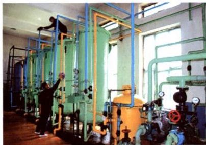
电厂水处理车间
