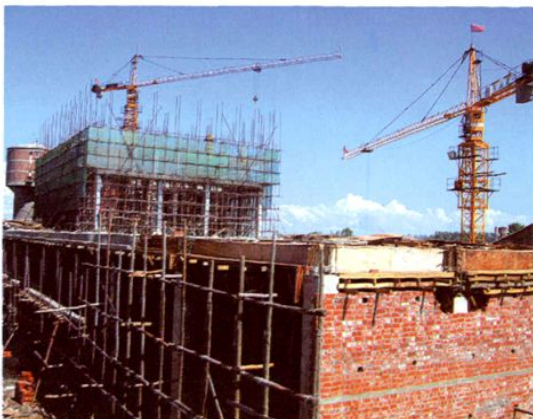
乳业公司日处理鲜奶 100 吨厂房建设工程
