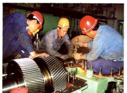
电厂汽机检修
