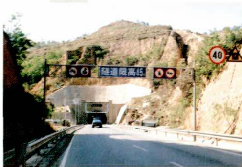
312国道彬县火石嘴隧道入口处
