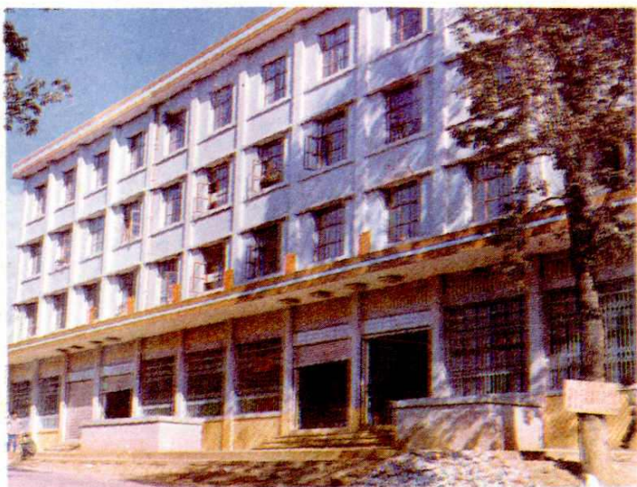
石林供销社新建综合 门市部及办公大楼
