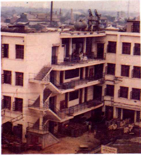
氯霉素车间(三车间)
