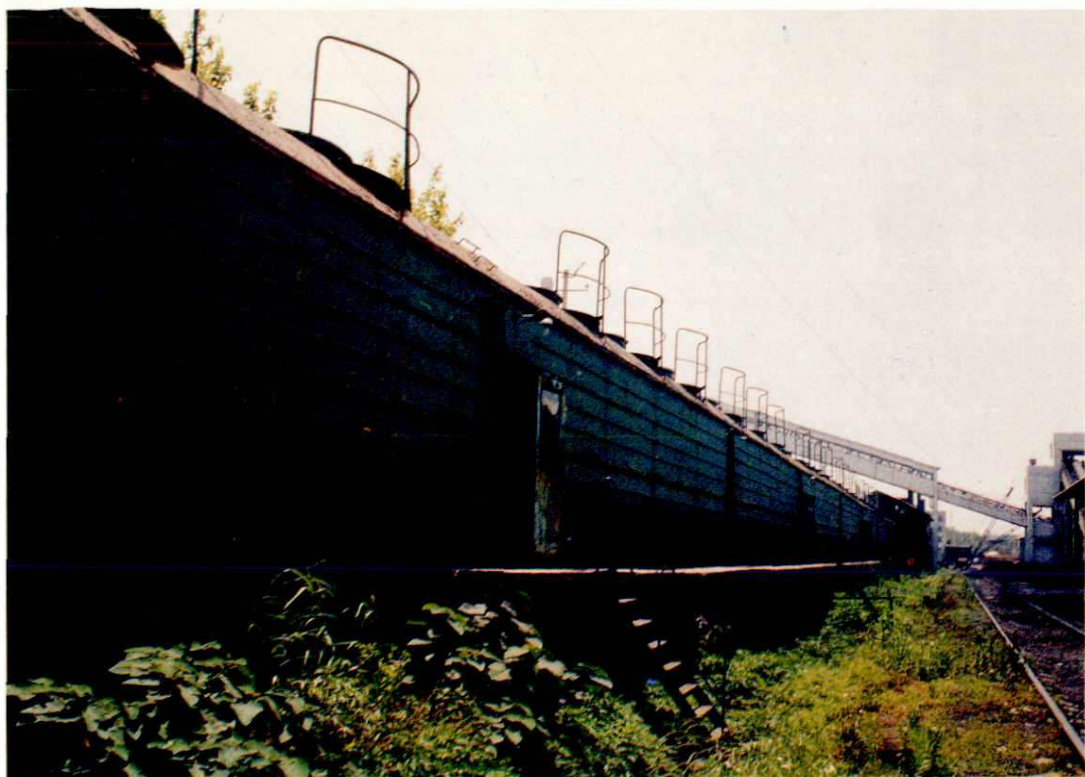
镇江市自备厂，安装列车发电机组容量6000千瓦
