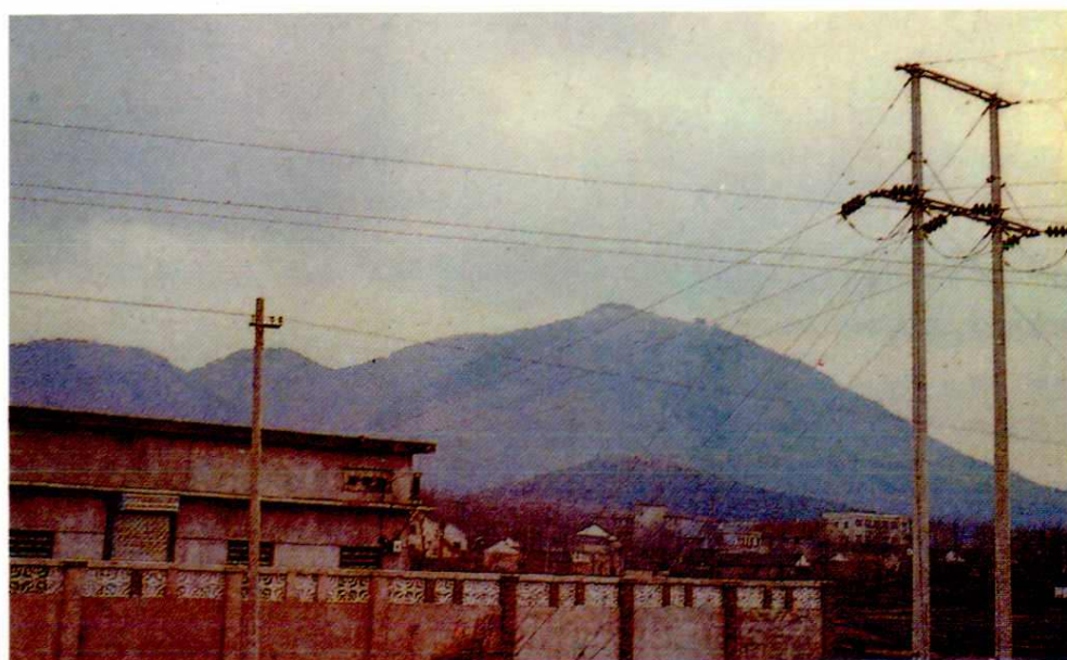
句容县茅山老区 35 千伏户内式变电所
