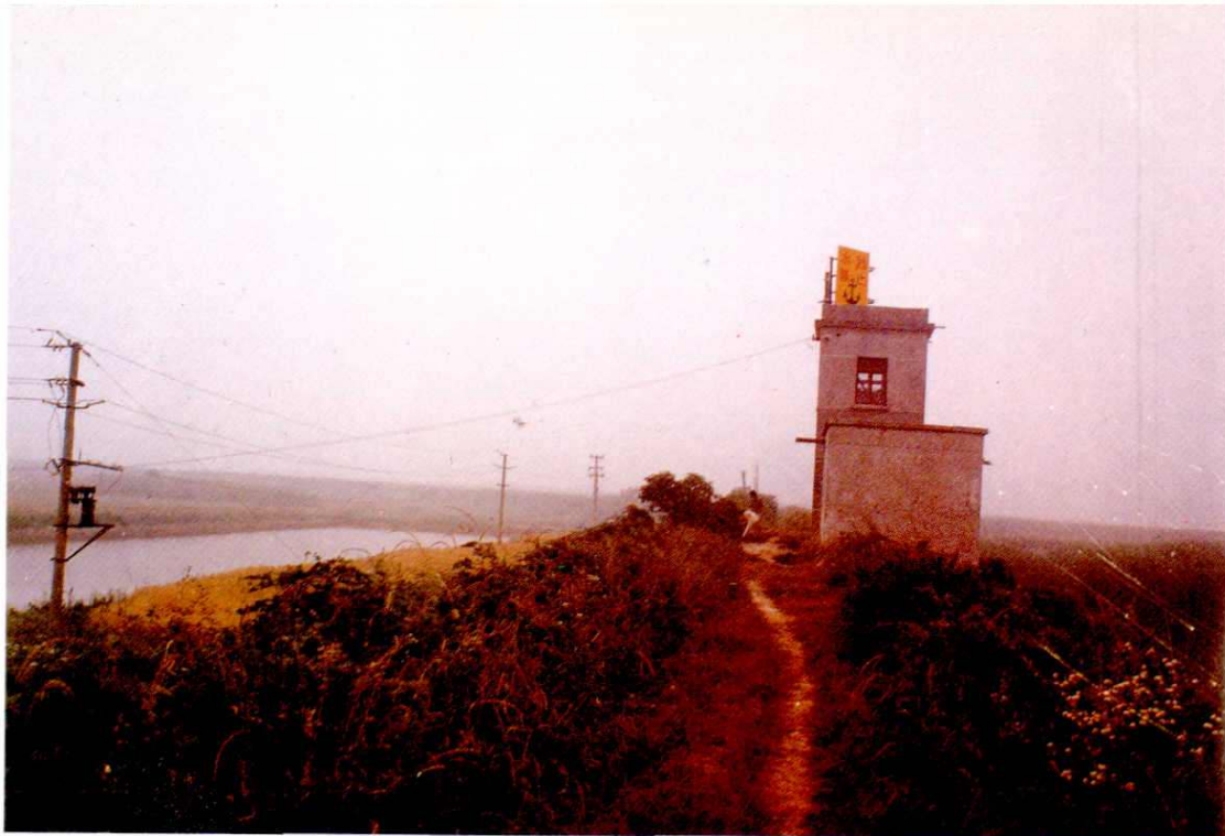
丹徒县高资 10 千伏 水下电缆监测室
