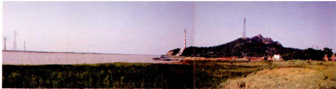
屹立长江两岸的 500 千伏徐沪线钢塔，220 千伏谏泰线钢筋混凝土塔。 左三为 1960 年架设的 110 千伏镇扬线木塔（已停用）
