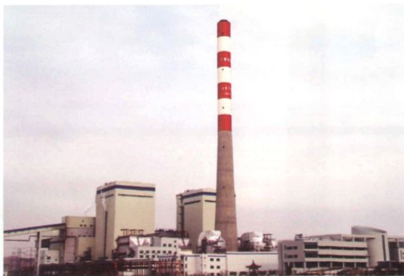
1991~2000年, 分别建 成投运的金川公司热电联产 自备电厂(装机 5 \times 0.6 + 1.2 万千瓦)
