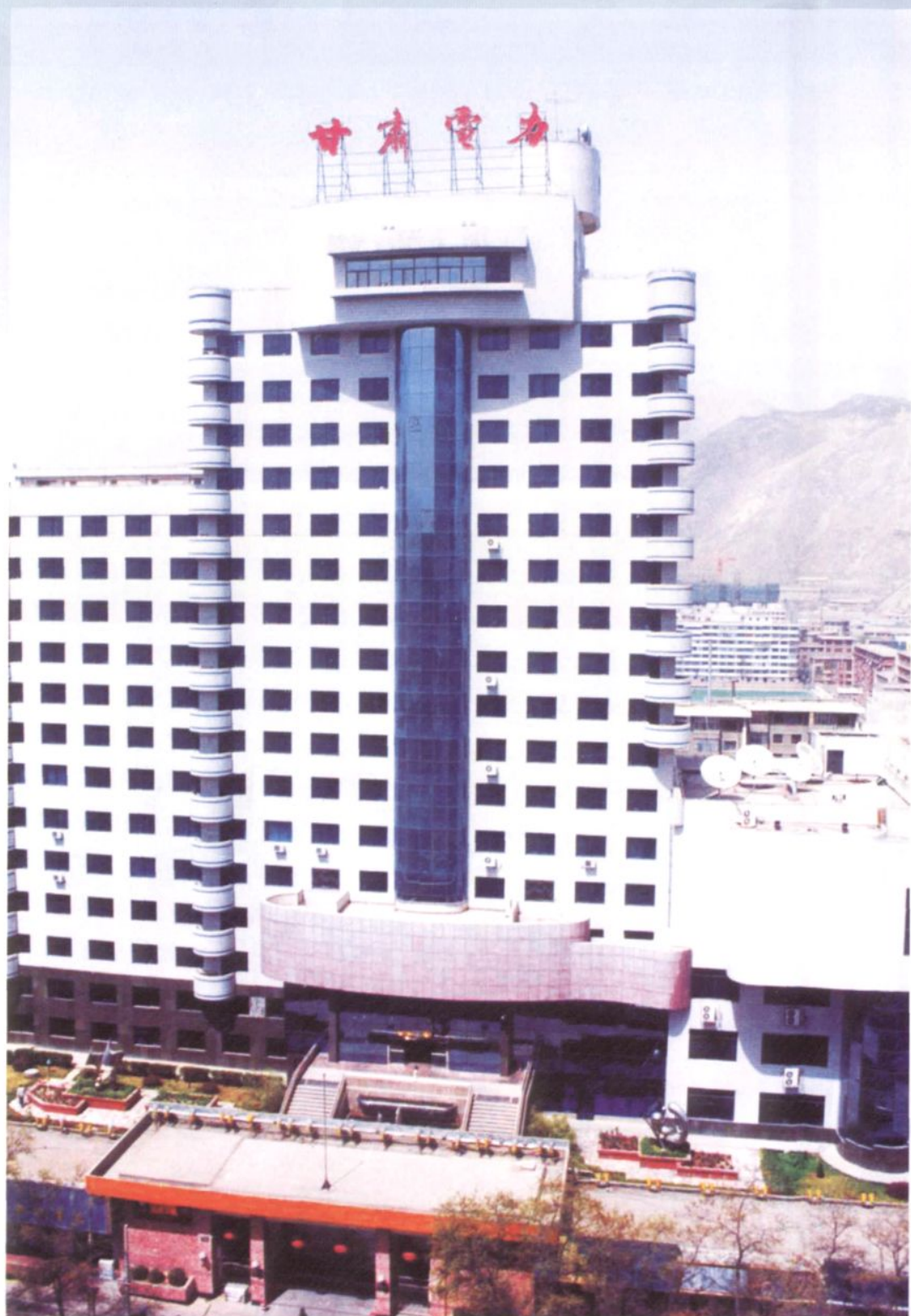
1992年落成的甘肃省电力工业局办公大楼
