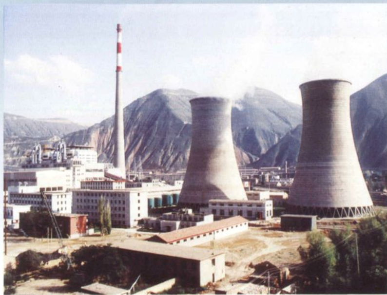
兰州第二热电厂(装机 20万千瓦)
