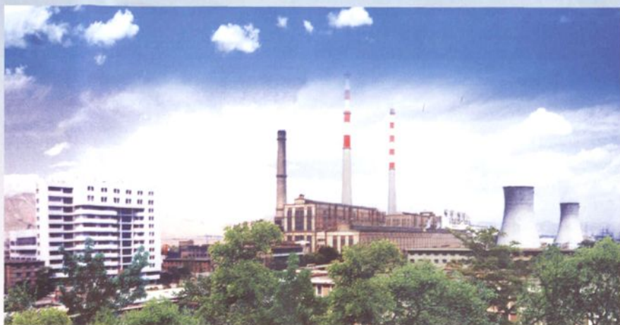
西固热电厂(装 机20+28.4万千瓦)
