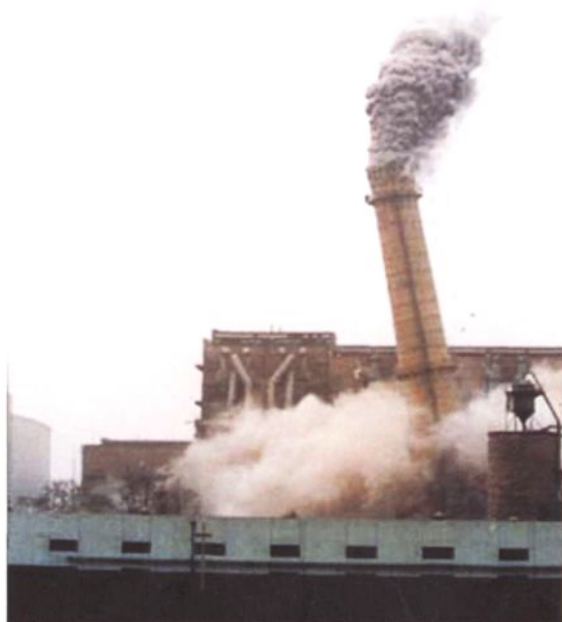
1999年3月31日，西固热电厂运行33年的小机组停运拆除。图为100米高的旧烟囱爆破场景
