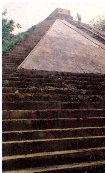
▶ 新民村营盘高扬程电力排灌站
