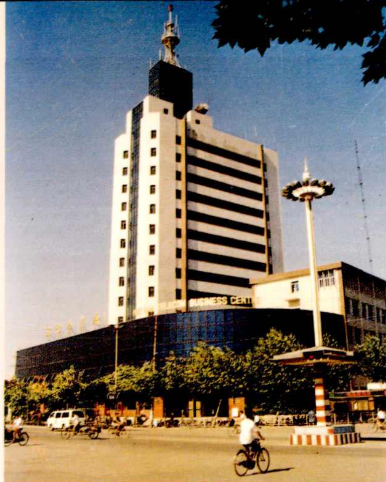
1. 位于电力路的镇江电信枢纽大楼, 1992 年 10 月 20 日竣工
