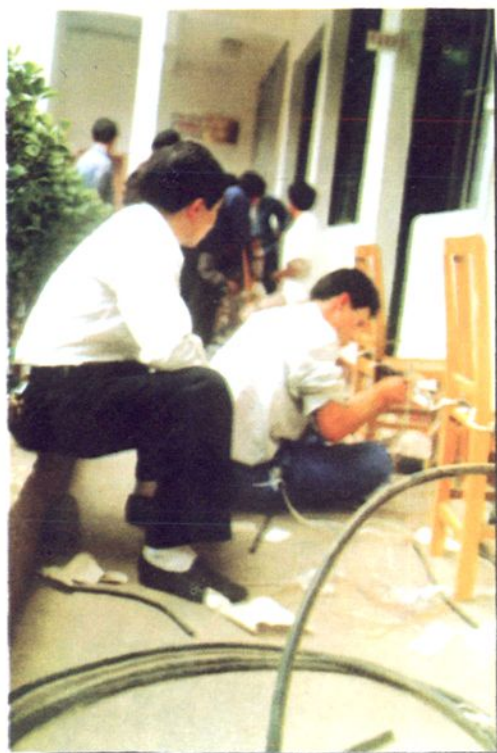
▼ 机线员正在认真进行电缆接序比赛
