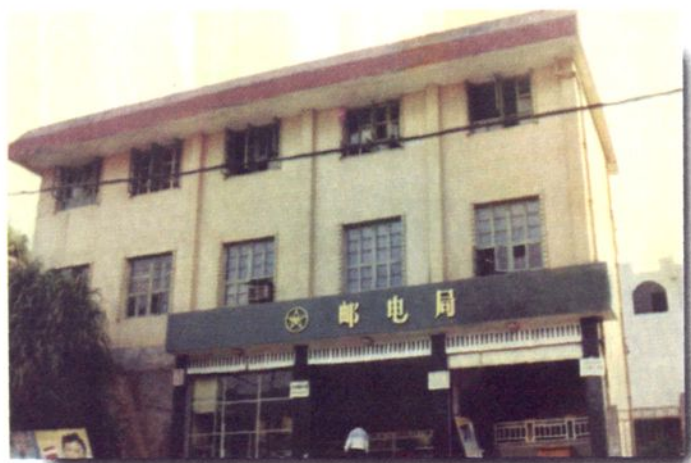
星村邮电支局营业厅及机房 ▶
