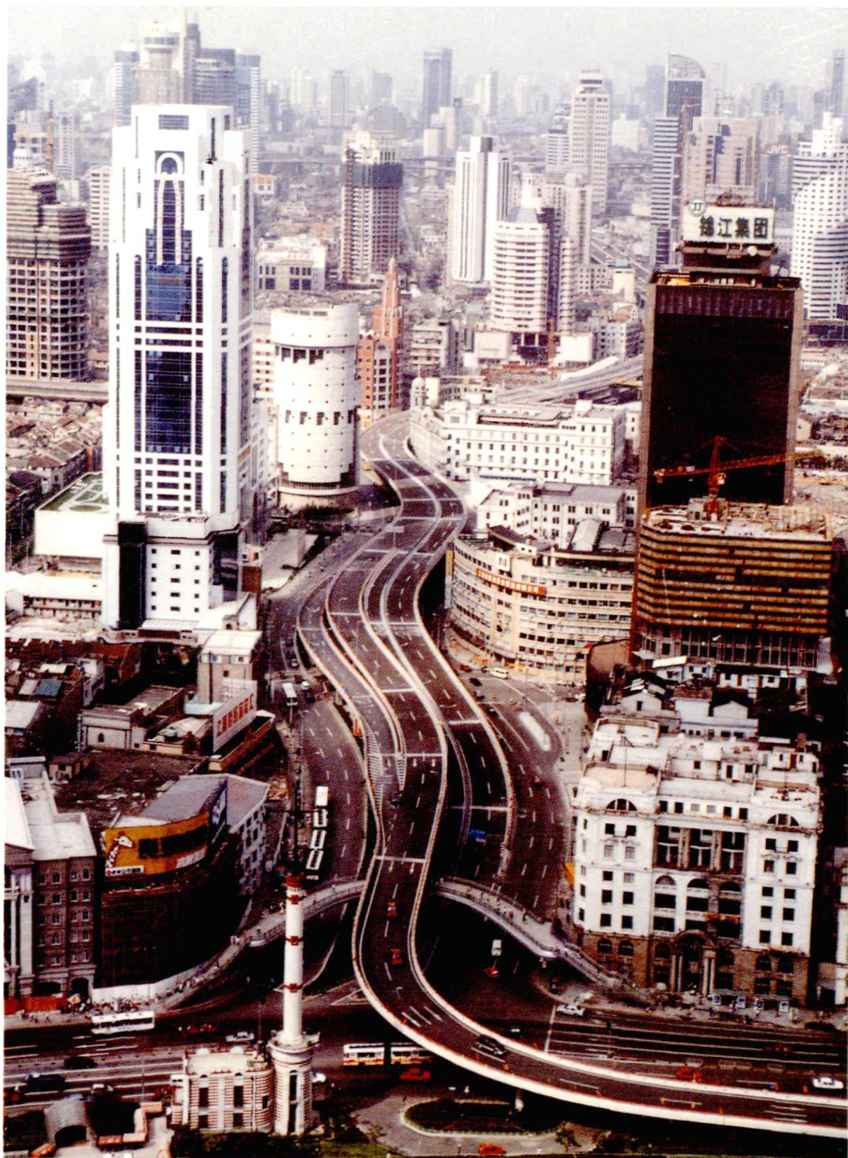
延安高架路东段
