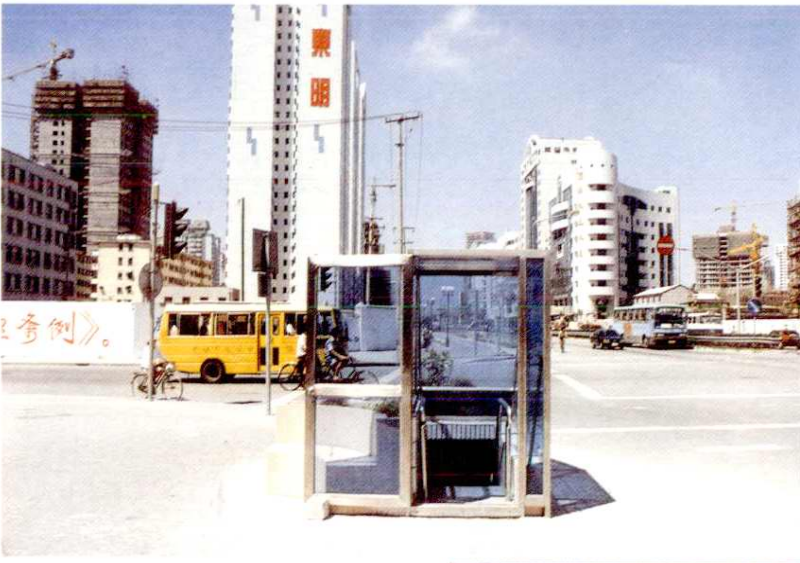
张杨路共同沟出入口
