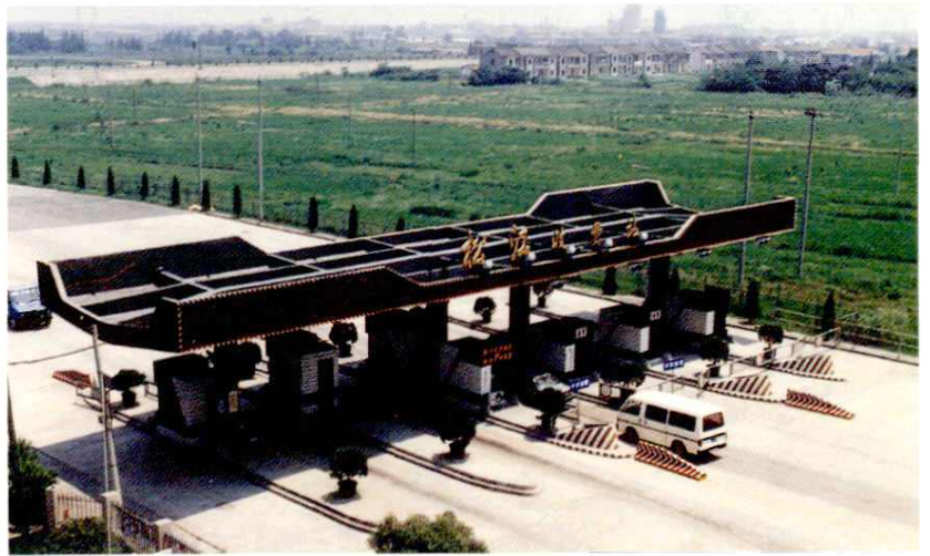
莘松高速公路松江收费口
