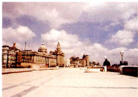
外滩防汛墙平台
