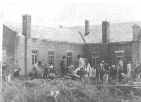
↑ 场部机关干部，自己 动手维修办公室。(1958.7)
