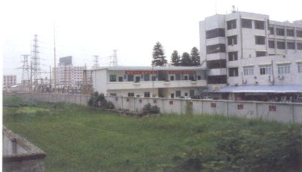
110千伏南庄输变电站
