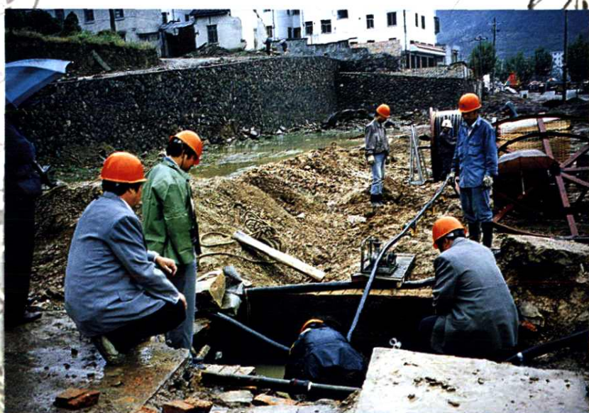
城网改造电缆入地
