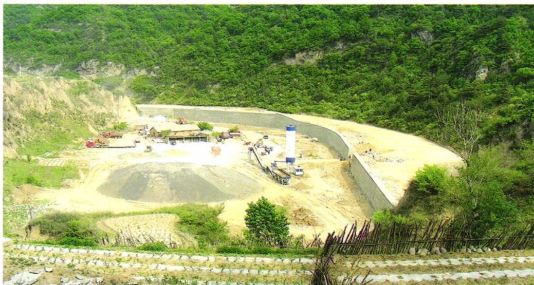
大峡谷旅游循环路树掌段在建工程
