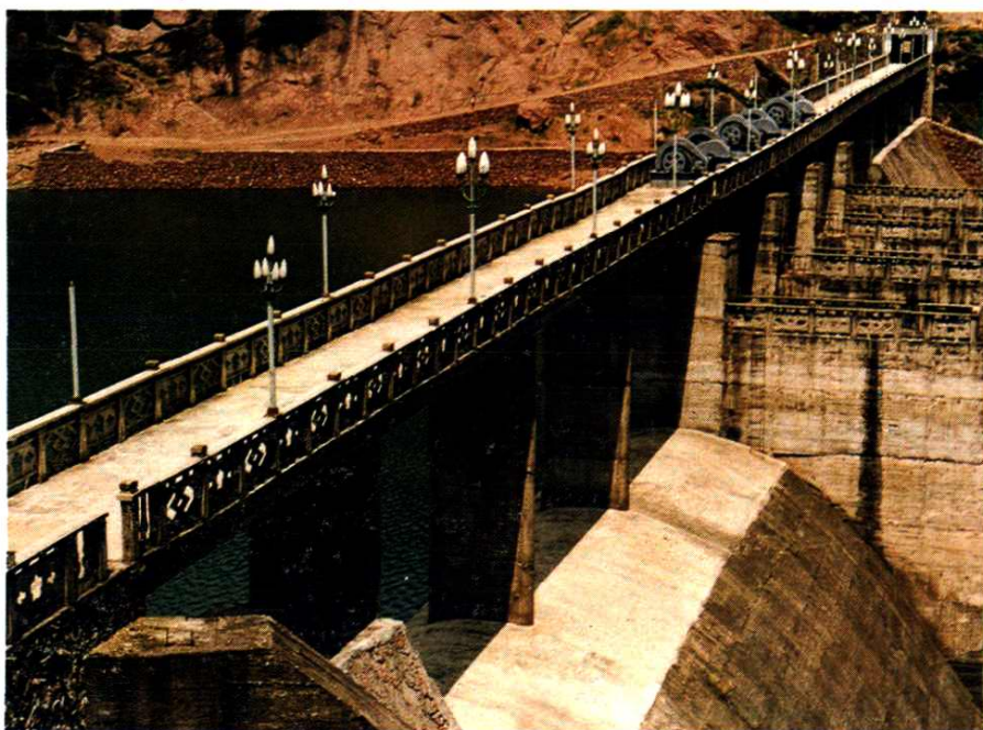
军潭水库混凝土重力坝
