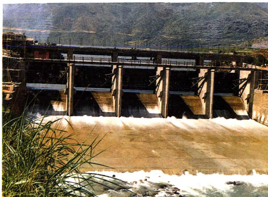
加固扩建中的七一水库电站溢洪道
