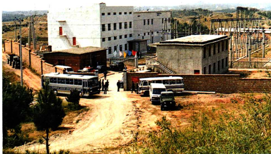
建成后的罗桥变电站全景。
