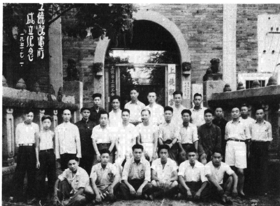
1951年上饒市配電所址及職工合影
