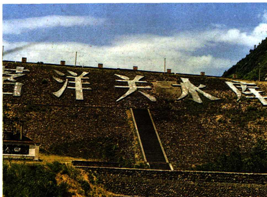
茗洋关水库大坝
