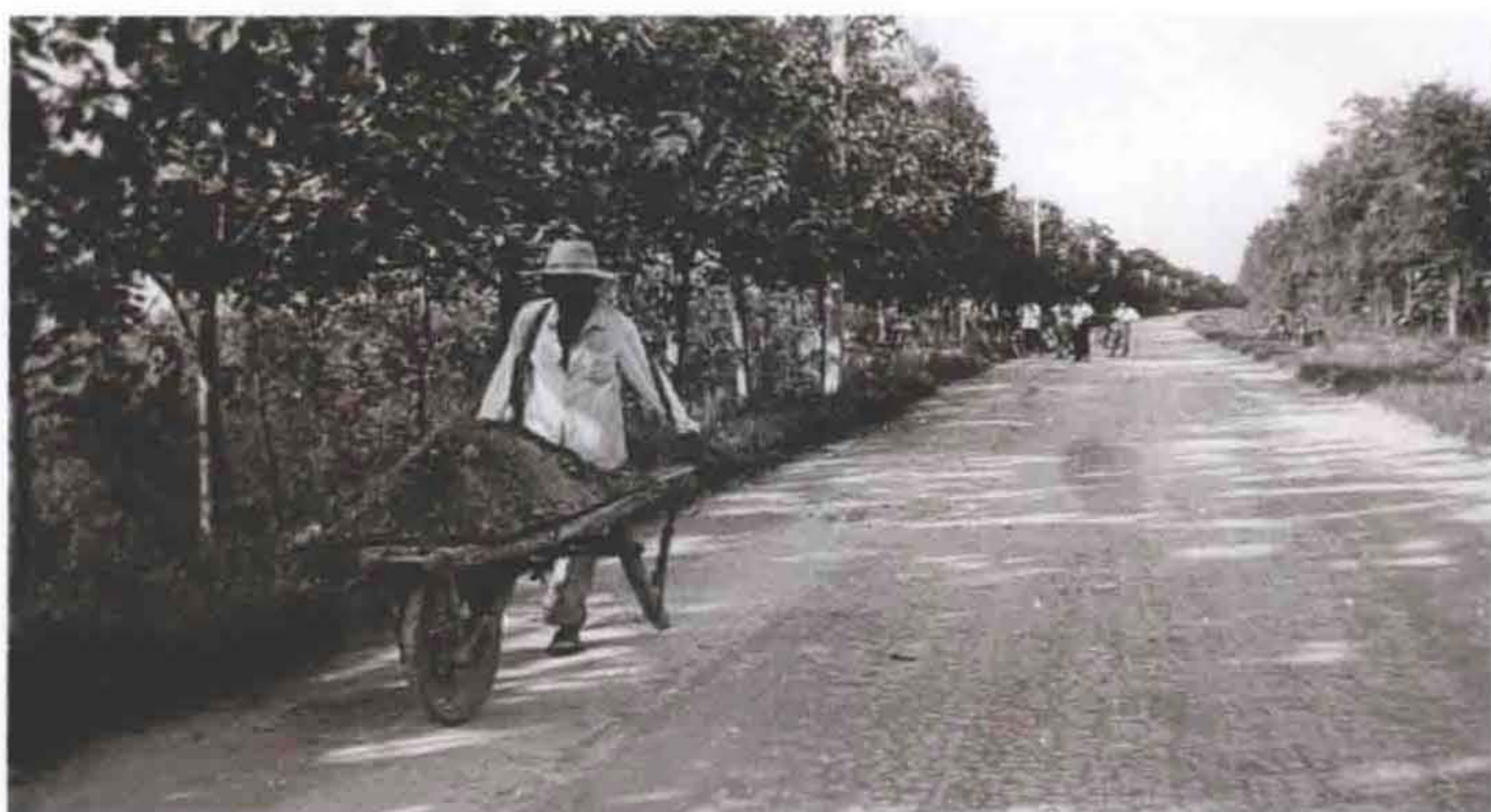
20世纪80年代，依靠人工维修养护堤顶
