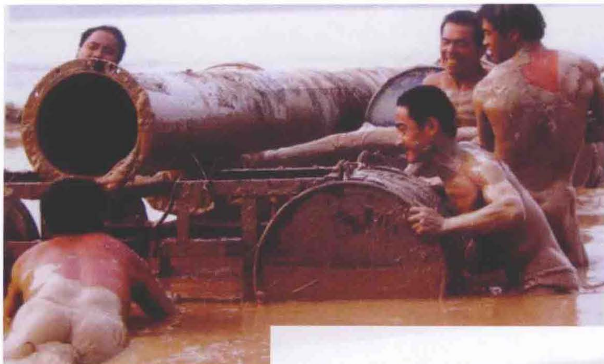
◀ 2004年，东明黄河标准化堤防建设者架设远距离输沙管道 ▼
