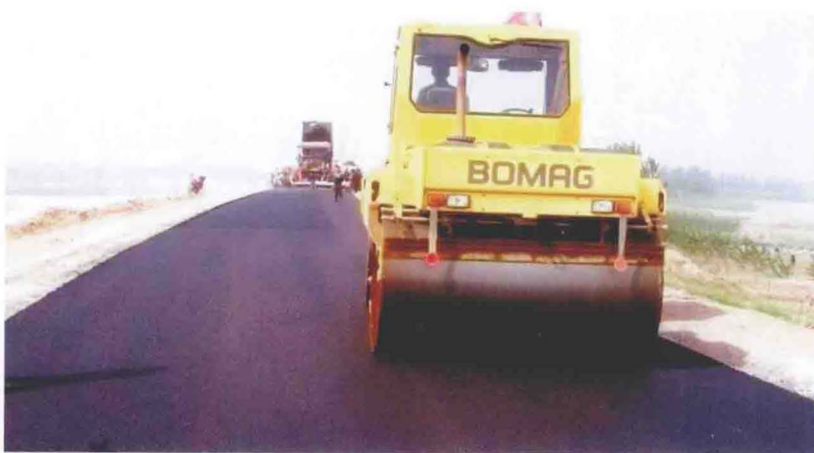
2005年东明黄河标准化堤防建设正在进行堤顶硬化
