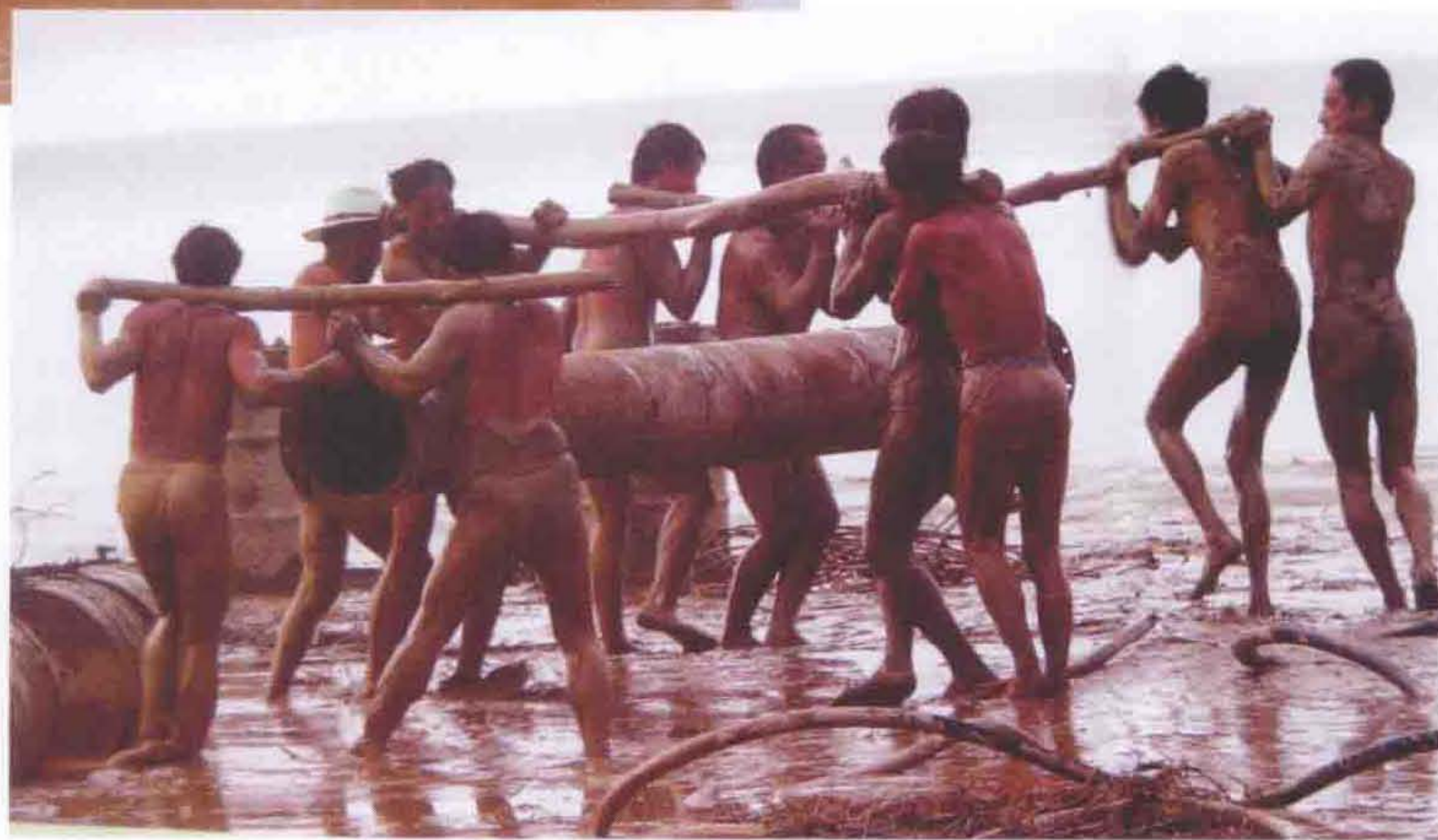
◀ 2004年，东明黄河标准化堤防建设者架设远距离输沙管道 ▼
