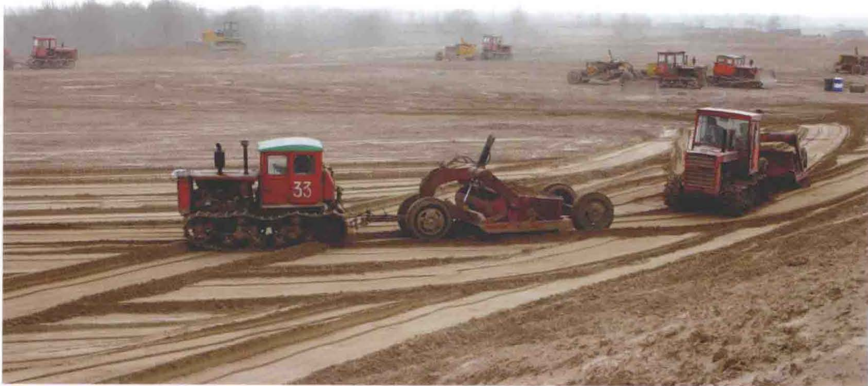
2004年东明黄河标准化堤防建设采取机械化联合施工作业
