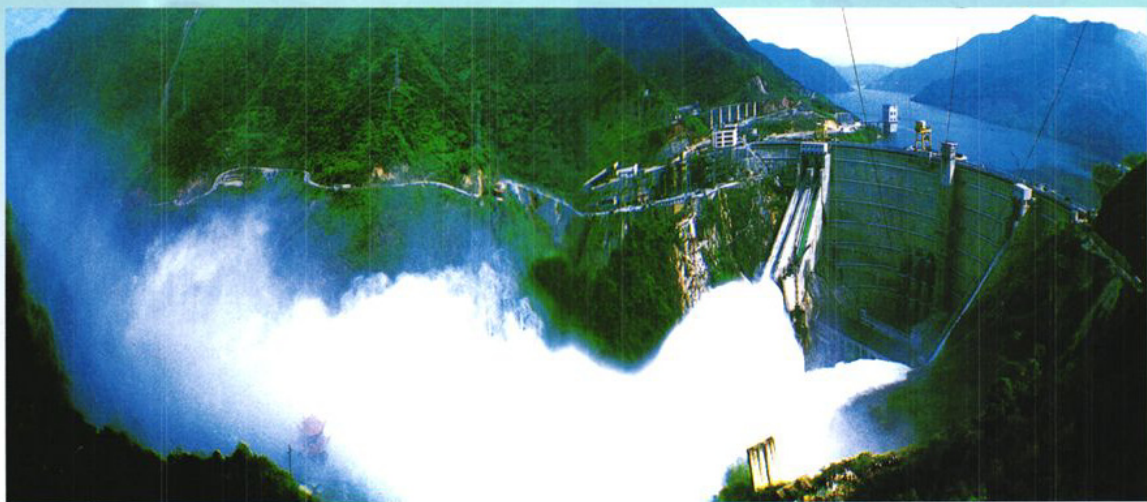
东江水电厂库容81亿米 3 ，装机50万千瓦。东江大坝是国内当时已建和在建的最高双曲拱坝
