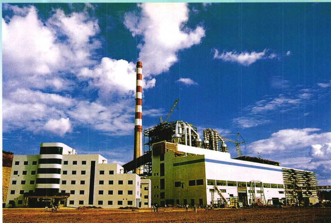
湘潭电厂一期工程1996年开工，1号机组1997年并网发电，比国家考核工期提前15个月，创同类型机组的新纪录
