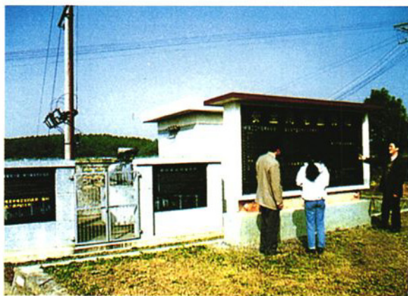
常德35千伏无人值班变电站
