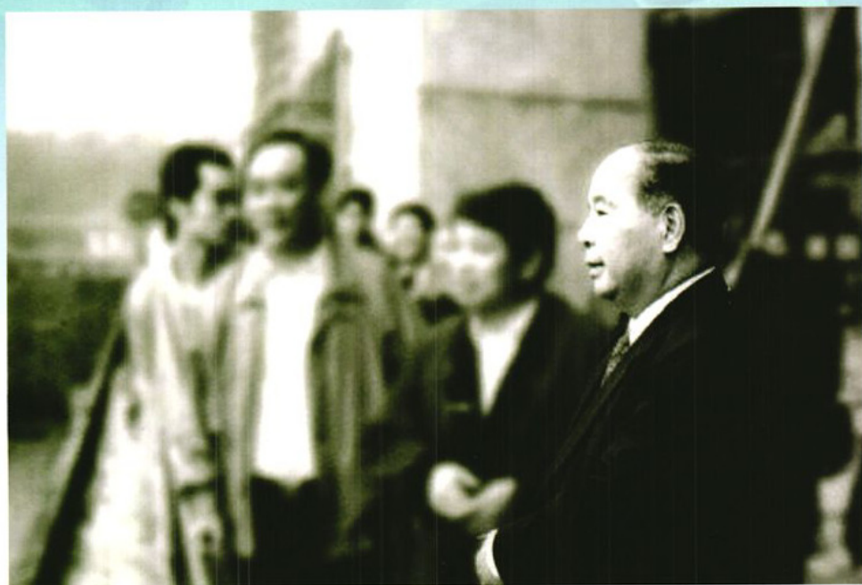
1994年10月，中共中央政治局常委、中纪委书记尉健行视察耒阳电厂二期工程扩建工地
