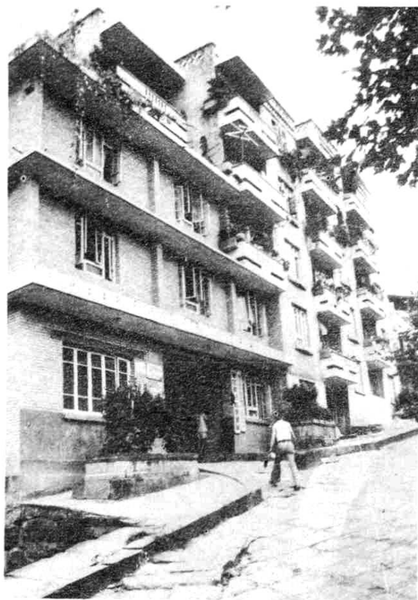
通江县妇幼保健站
