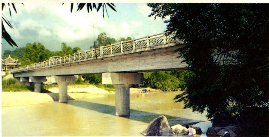
首次采用单柱式桥墩建造的龙门榜头大桥
