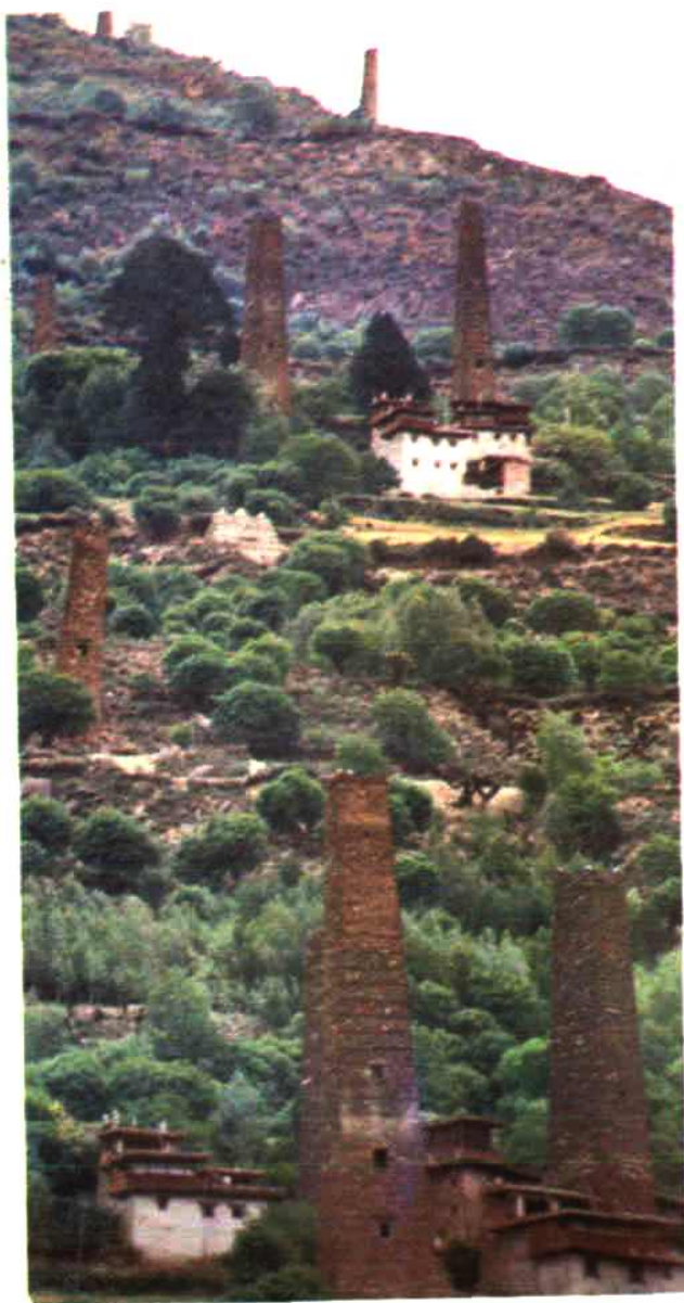
丹巴梭坡碉寨一角
