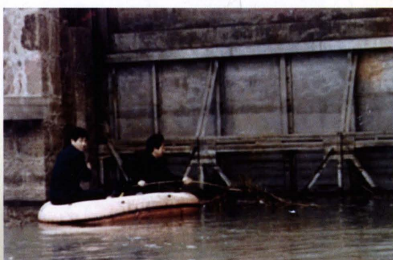
打捞漂浮物监测螺情（京杭大运河、南运西闸）
