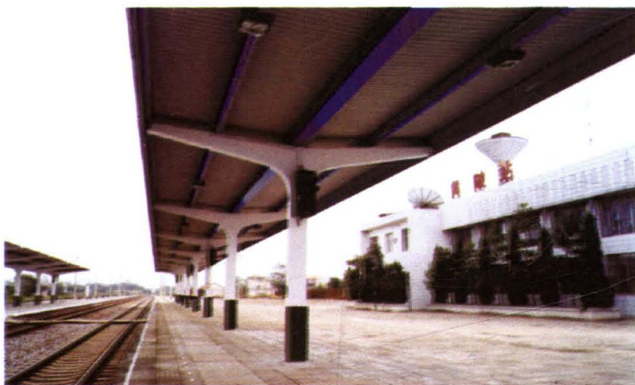
京九铁路武麻联络线上的黄陂火车站
