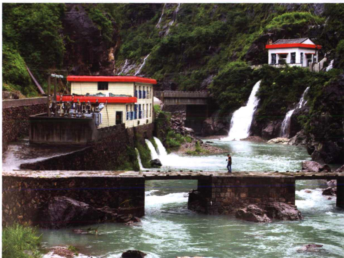
陡门溪水电站(左)和山溪头水电站(右)
