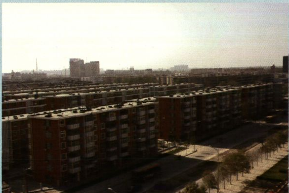
改造后，面貌一新的集贤里街一角
