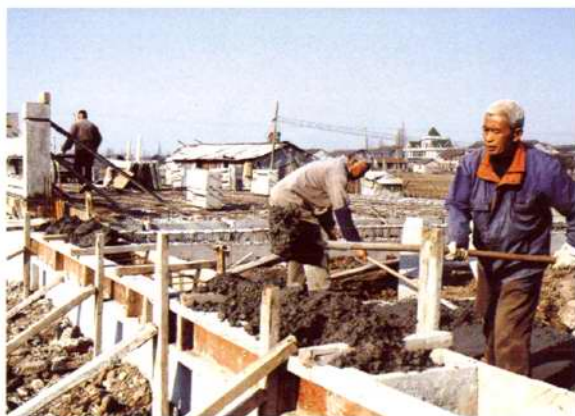
桥梁改建工程
