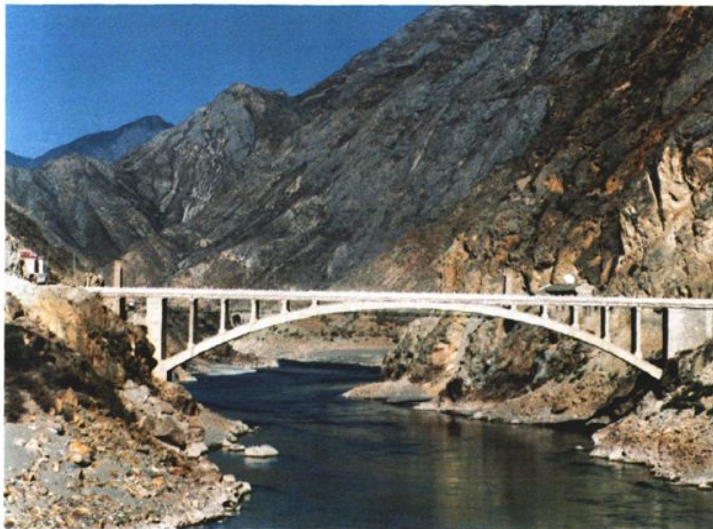
金沙江伏龙大桥
